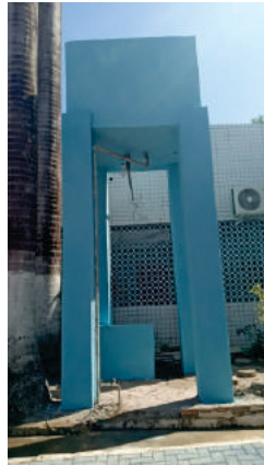
Recuperação Estrutural Dircon / Recife
